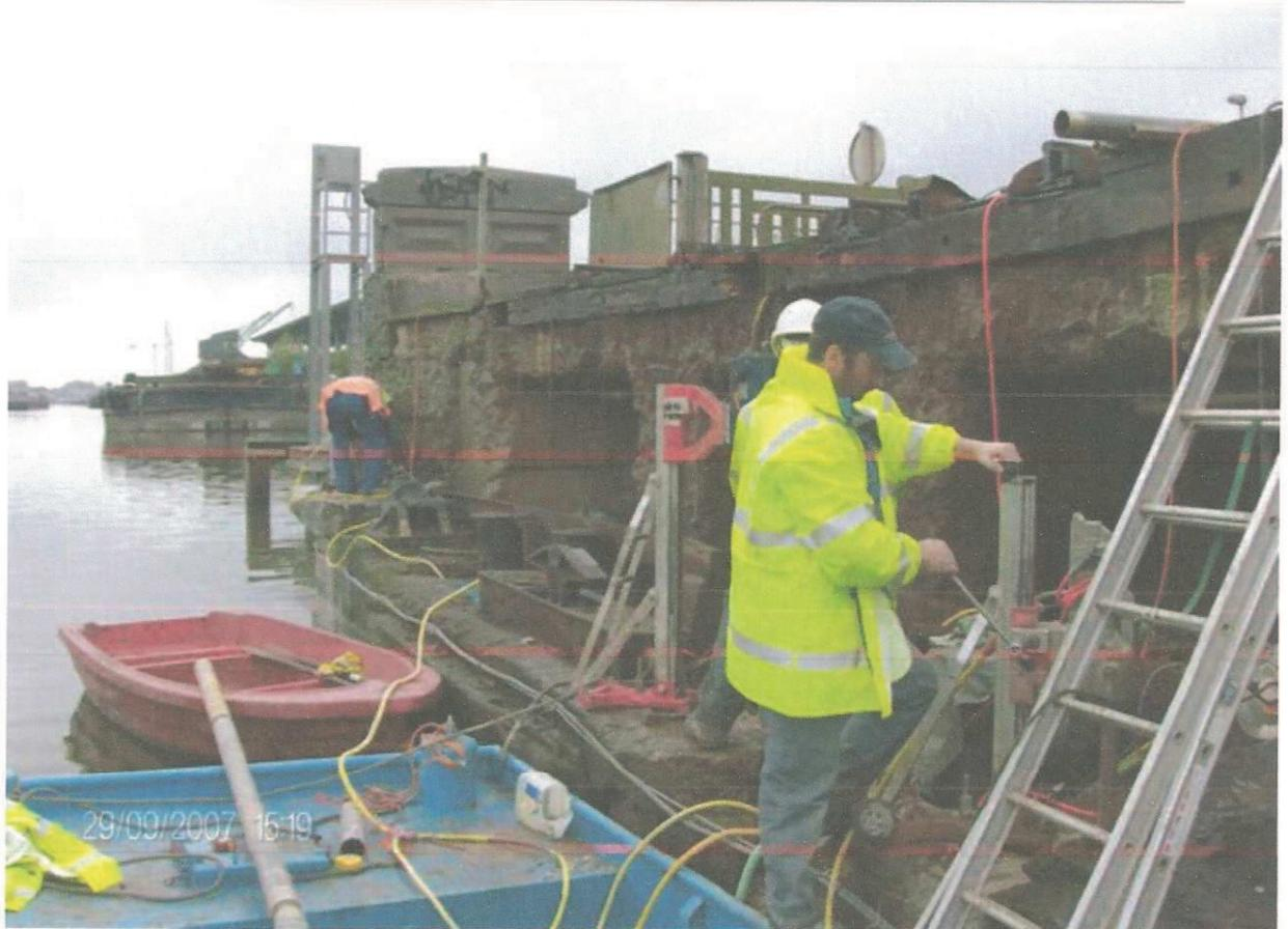
Forage d'ancrage à travers pile de pont de chemin de fer (Gand - Belgique)
