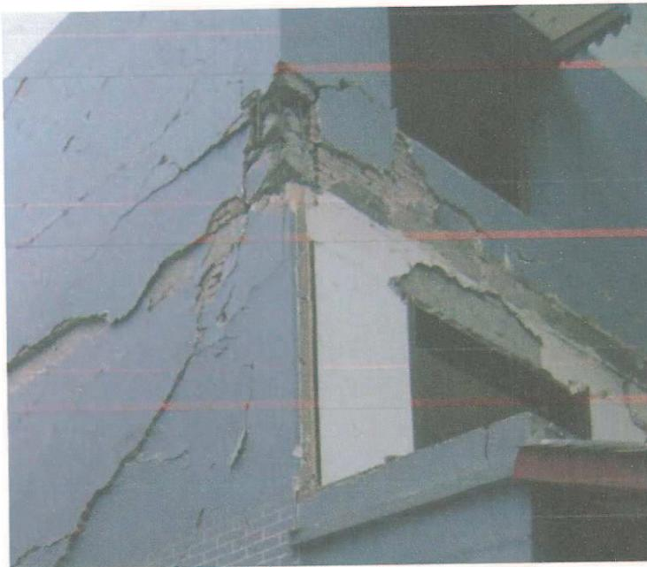
Rupture tête de colonne due à poussée de la maçonnerie
