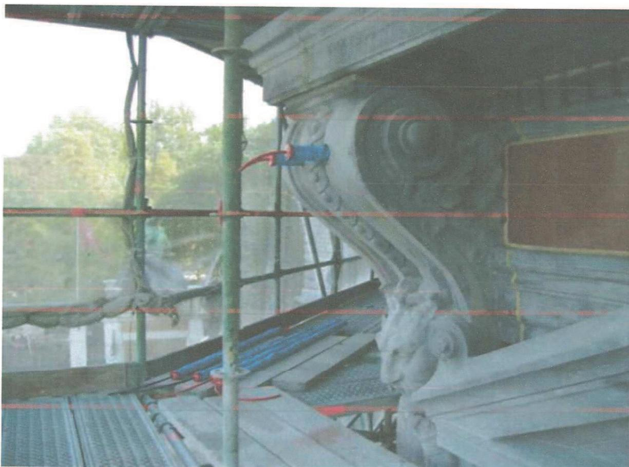
Ancrages ARL placés dans mur, avant injection (Anvers - Belgique)
