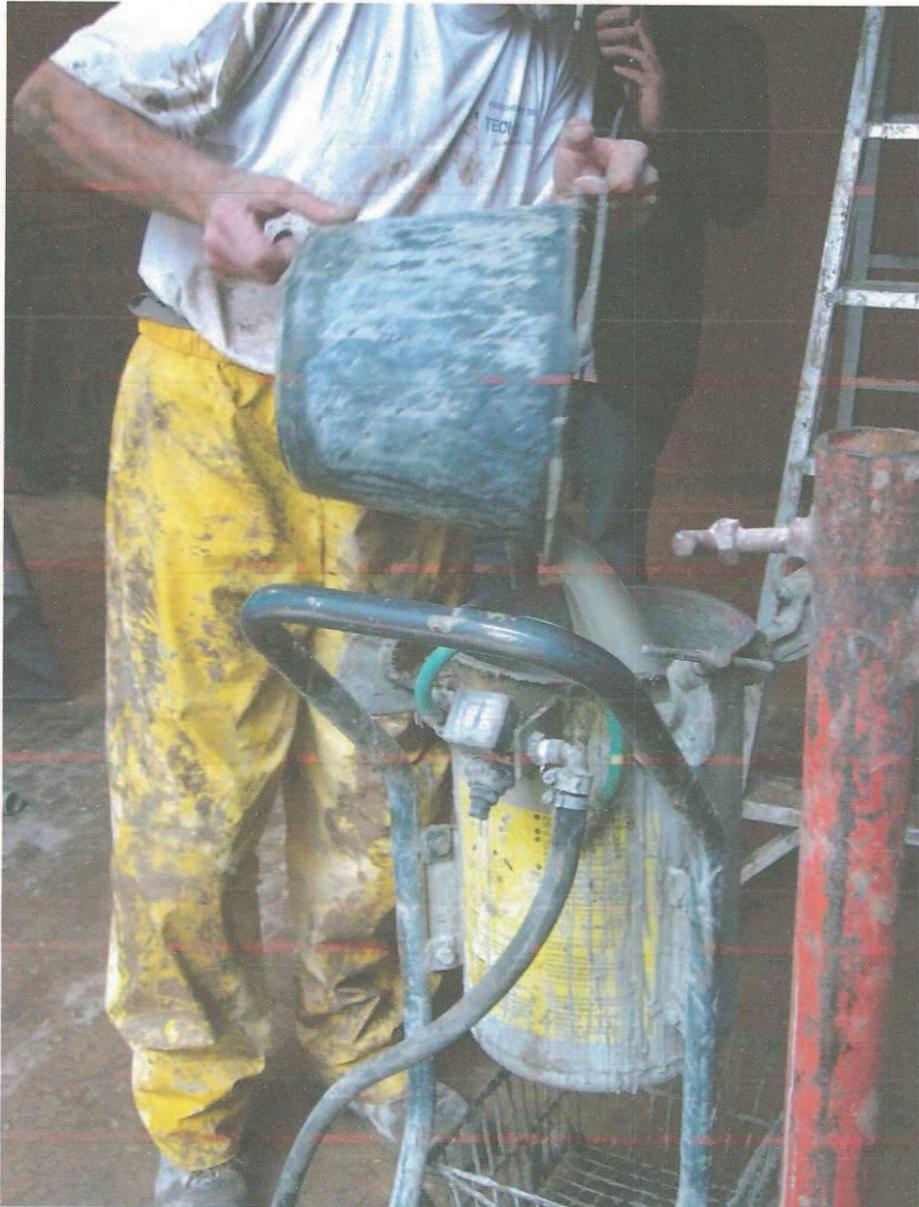
Fig-3 Versement du coulis dans la cuve d'injection
